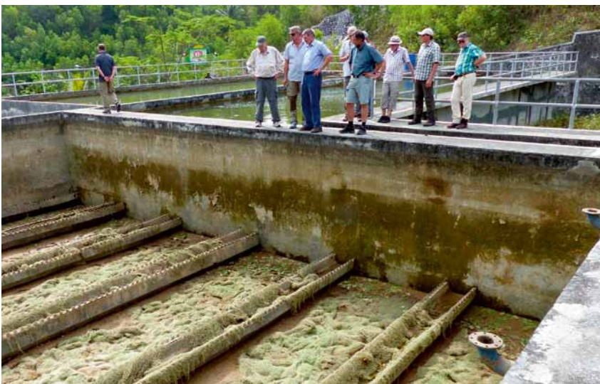
Sandfilterbecken, abgelassen zur Reinigung
