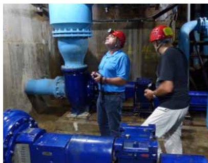
Kraftwerk/Wasserpumpen, 100 m unter der Erde
