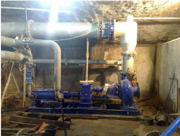
Abb. 16: Installiertes KSB-Fördermodul
