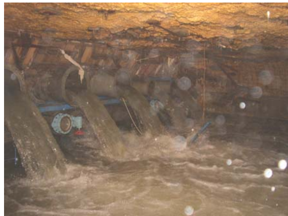
Abb. 15: Partieller Einstau des Sperrwerkes während eines Hochwasserereignisses wenige Tage nach Abschluss der Betonierarbeiten
