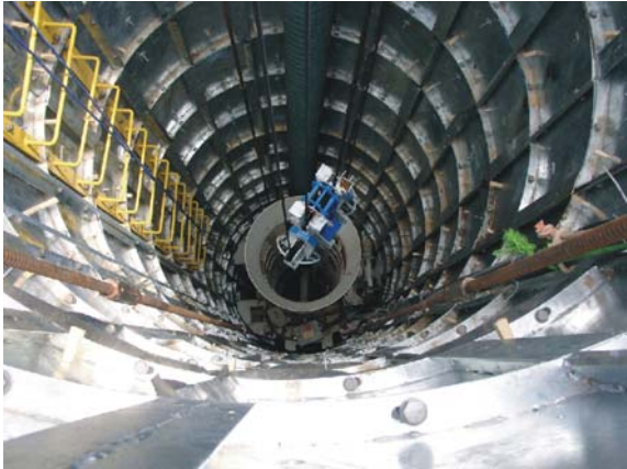
Abb. 9: Blick in den Zugangsschacht
