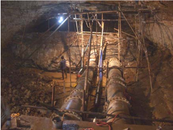
Abb. 14: Stand der Bauarbeiten Dezember 2005
