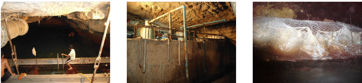
Abbildung 8: Verstärkung der Saugrohre im Unterwasser durch Stahlträger (links), Erhöhung der unterwasserseitigen Schutzmauer (Mitte), Schutzmauer nach Fertigstellung der Erhöhung (rechts)
