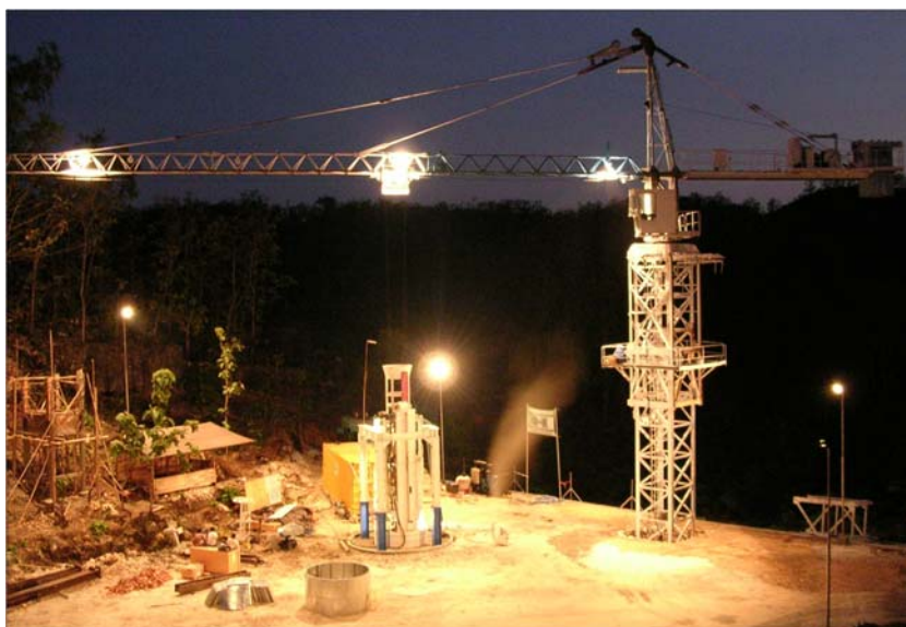
Abb.12 Schachtbaustelle 2004 (oben: nach Ausbau einer Zufahrtsstraße; Mitte: Vorbereitung der Baustelleninfrastruktur; Unten: Beginn der Bohrarbeiten)
