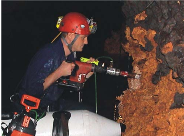
Abb.15 Gesteinsuntersuchungen im Bereich des geplanten Sperrwerks
