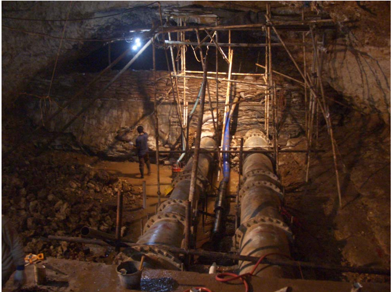
Abb.17 Stand der Bauarbeiten Dezember 2005
