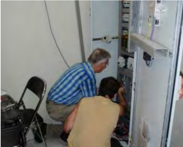
SPS Panel an Aufzughaus
