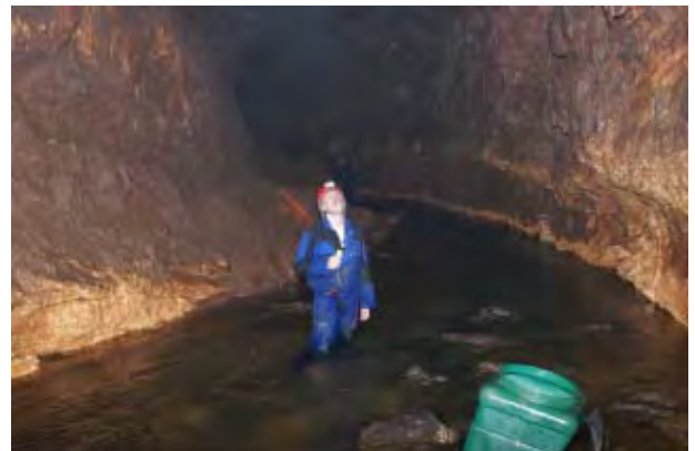
Zukünftige Position der Wasserförderanlage
