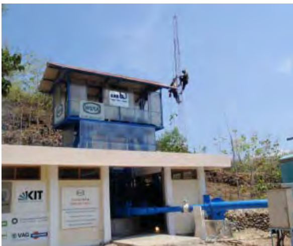
Installation der Antenne für die Datenkommunikation
