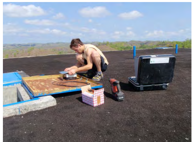
Installationen des Wasserspiegelmonitoring inkl. Datenübertragung zum Reservoir Kaligoro
