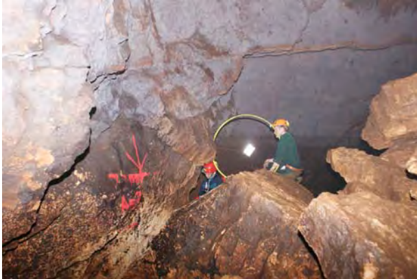
Kurz vor dem 1. Wasserfall – Felsen in der Trasse
