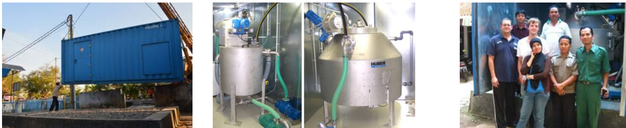
Abbildung 4: Installation und Inbetriebnahme der Anaerobanlage am Krankenhaus Wonosari (links), technische Ausstattung für Hydrolyse-Verfahren (Mitte), Inbetriebnahme der Anlage am Krankenhaus Wonosari (rechts)
