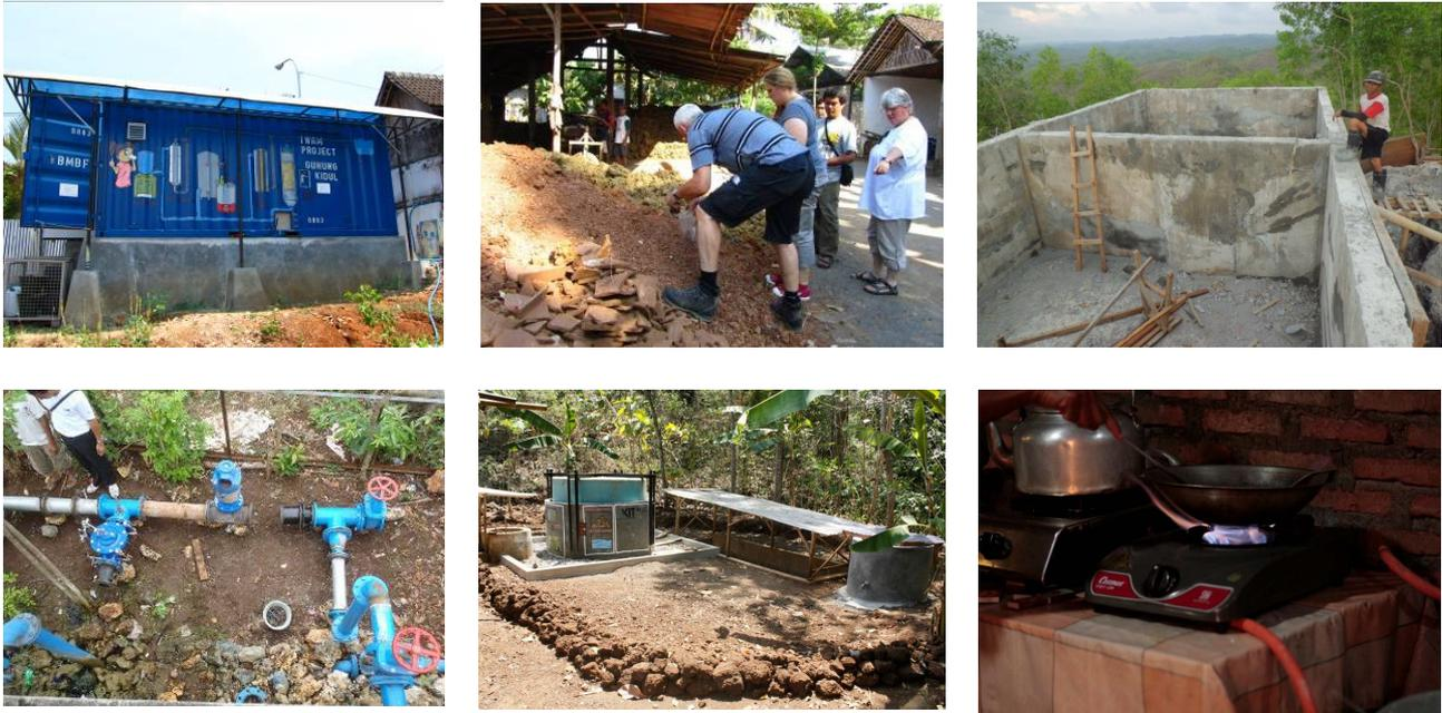
**Abbildung 3:** Feldlabor zur Hygienisierung des Wassers im Krankenhaus Wonosari (oben links), Begutachtung der lokalen Tonproduktion (oben Mitte), Betonarbeiten an der *Slow-Sand-Filtration*-Anlage auf dem Hügel Kaligoro (oben rechts), Installation von Armaturen in einer neuen Trasse des Verteilnetzes Bribin (unten links), Fertigstellung von Biogasreaktoren in Pucanganom (unten Mitte), Anwendung des erzeugten Biogases durch die lokale Bevölkerung (unten rechts)
