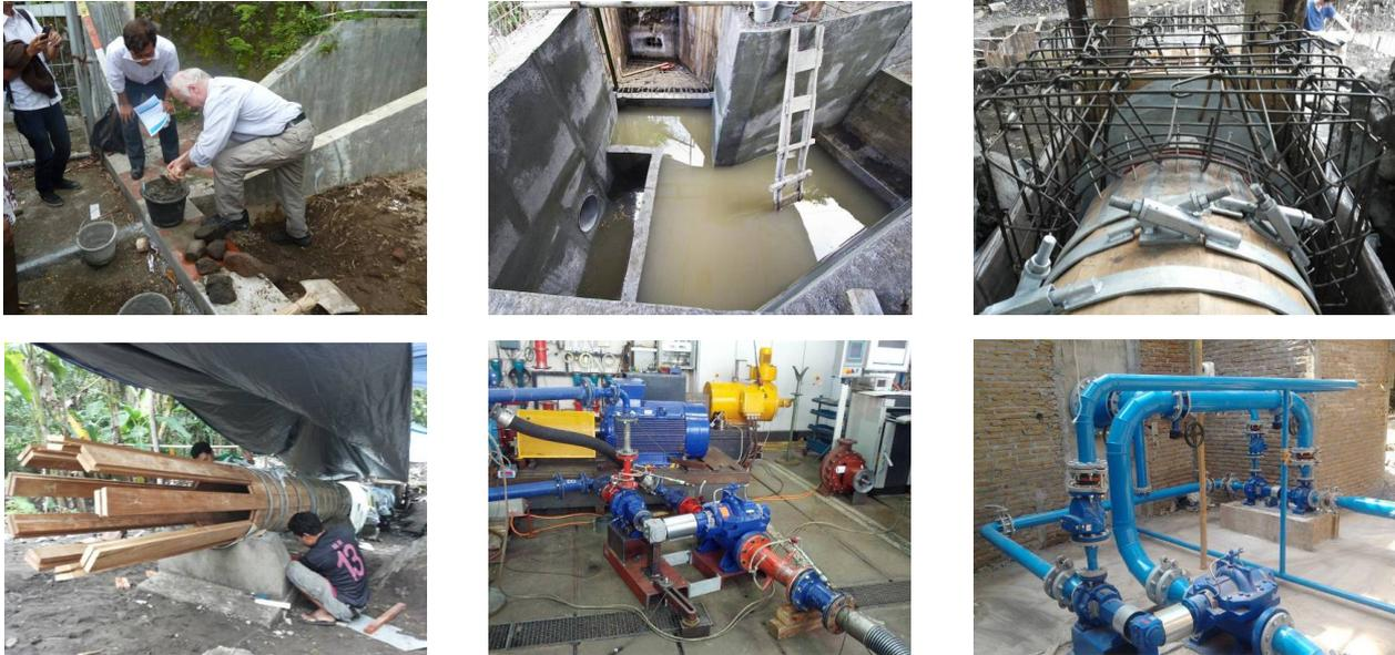
**Abbildung 2:** Kick-Off-Meeting (oben links), Bau des Einlaufbeckens (oben Mitte), Realisierung des Betonwiderlagers für das Holzdruckrohr (oben rechts), Bau des Holzdruckrohrs (unten links), Analysen der Fördermodule auf dem KSB-Prüffeld (unten Mitte), Fertigstellung des Wasserförder- und Rohrleitungssystems (unten rechts)
