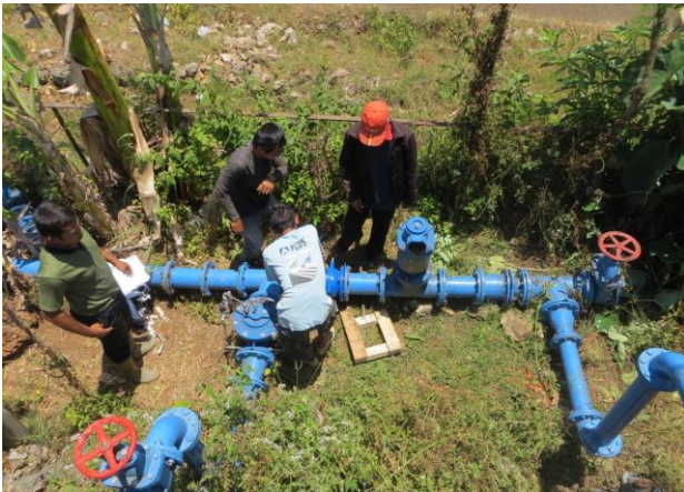
Abbildung 3: Implementierung der ersten Steuerungseinheit zur Optimierung des Verteilnetzes Bribin (links), messtechnische Validierung des Konzeptes vor Ort durch TP1B IWG/WK in Zusammenarbeit mit indonesischen Partnern (rechts), Oktober 2014
