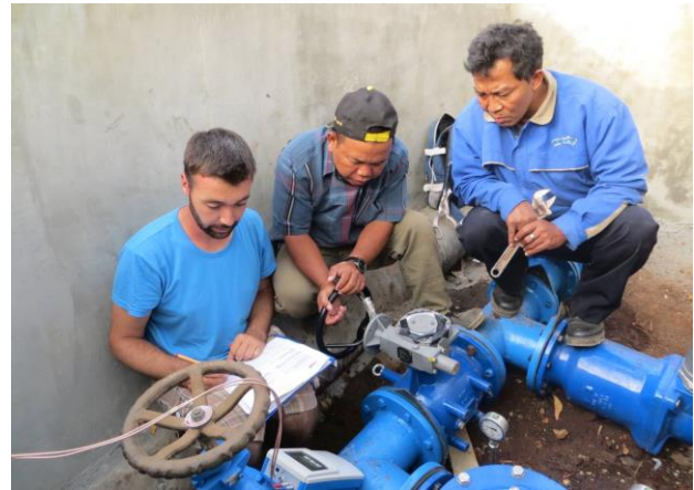
Abbildung 3: Implementierung der ersten Steuerungseinheit zur Optimierung des Verteilnetzes Bribin (links), messtechnische Validierung des Konzeptes vor Ort durch TP1B IWG/WK in Zusammenarbeit mit indonesischen Partnern (rechts), Oktober 2014
