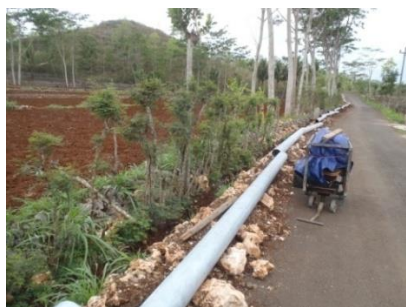
(d) Implementation: Installation of main line
