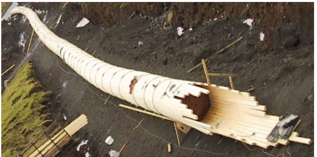
Beispiel einer Holzdruckrohrleitung für Variante 2: Nutzung einer unterirdischen Druckrohrleitung aus Holz als Zuleitung zur Kleinwasserkraftanlage
