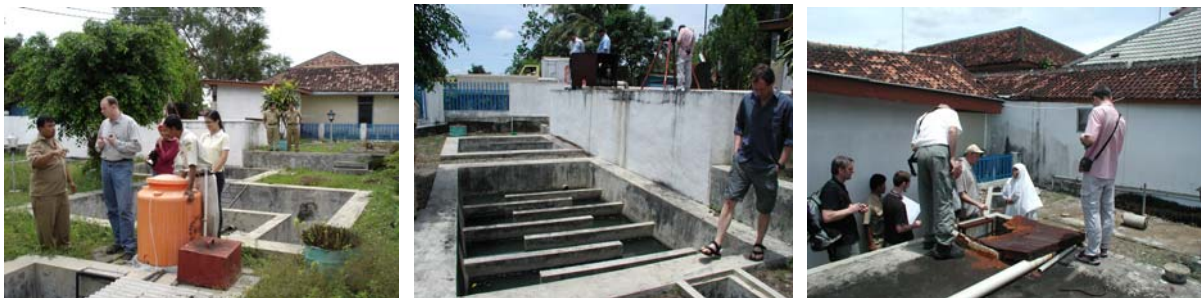
Abb. 16: Kläranlage im Krankenhaus der Stadt Wonosari [Quelle: IWG-SWW]
