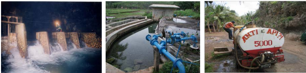
Abb. 11: „Öffentliche“ Wasserversorgung durch Wasser aus Karsthöhlen (links), Karstquellen / Tiefbrunnen (Mitte) und mittels Tankwagen als teuerste Variante (rechts)
