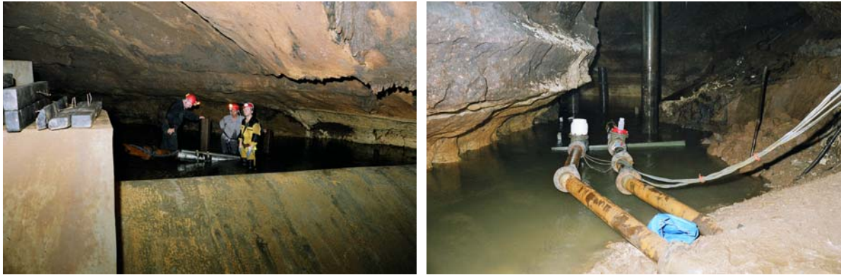
Abb. 15: Wehranlage und Förderpumpen in der Höhle Seropan
