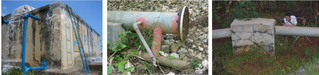
Abb. 12: Mängel an Leitungen und Bauwerken des Verteilungnetzes [Quelle: IfMB]
